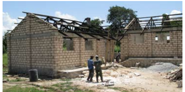
Unterrichtsräume im neuen Heim für Straßenkinder in Kikambala / Mombasa.
