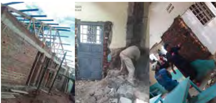
Neubau der Küche und Mensa von den ersten Steinen bis zu den Fenstern
