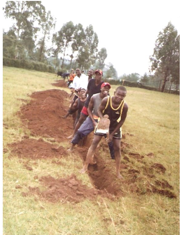
Die neue Wasserleitung für 1000 Schüler wird verlegt.
